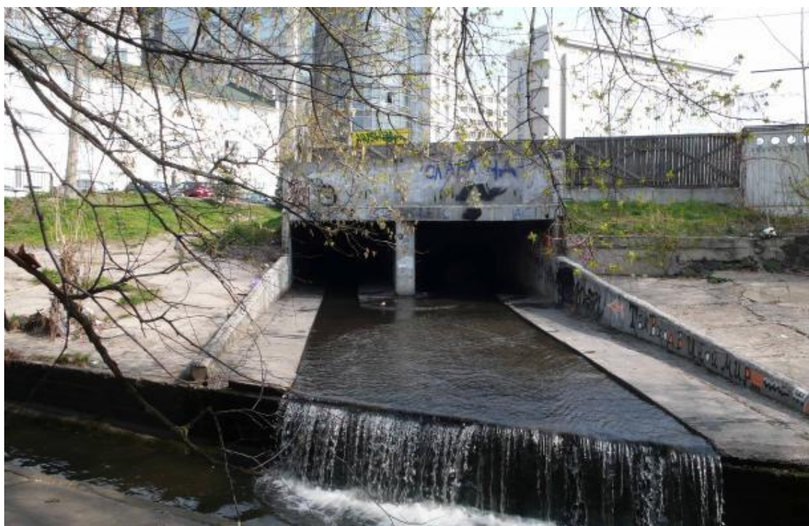
Рис. 4.56. Прозорівський портал колектору дощової каналізації (гирло р. Клов)
