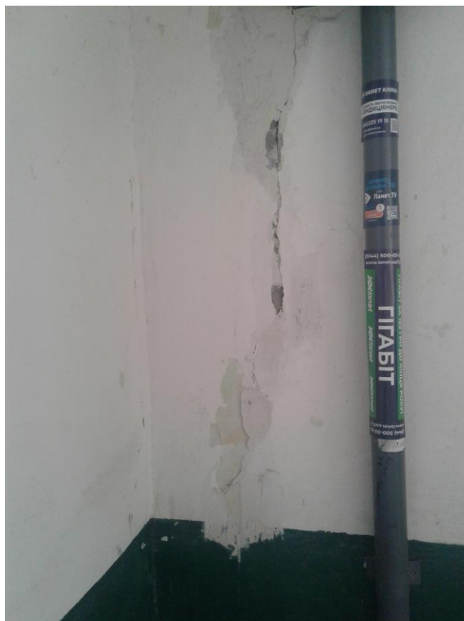
Рис. 4.32. Стан залізобетонної стіни у будинку на Оболоні після землетрусу 1977 р. Фото 2020 р.
