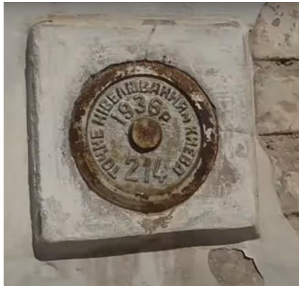
Стінний репер нівелювання (вул. Темірязевська, 3)
